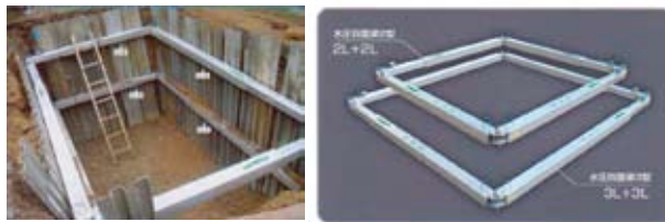
1 予掘 2 スライドレールのたて込み 3 パネルの挿入 4 スライドレールのたて込み
