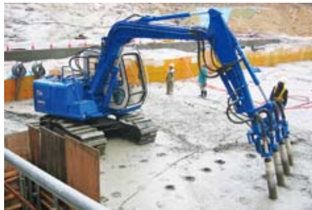
VBH74EHL 打設状況
