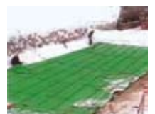
ダム放水口修繕工事
